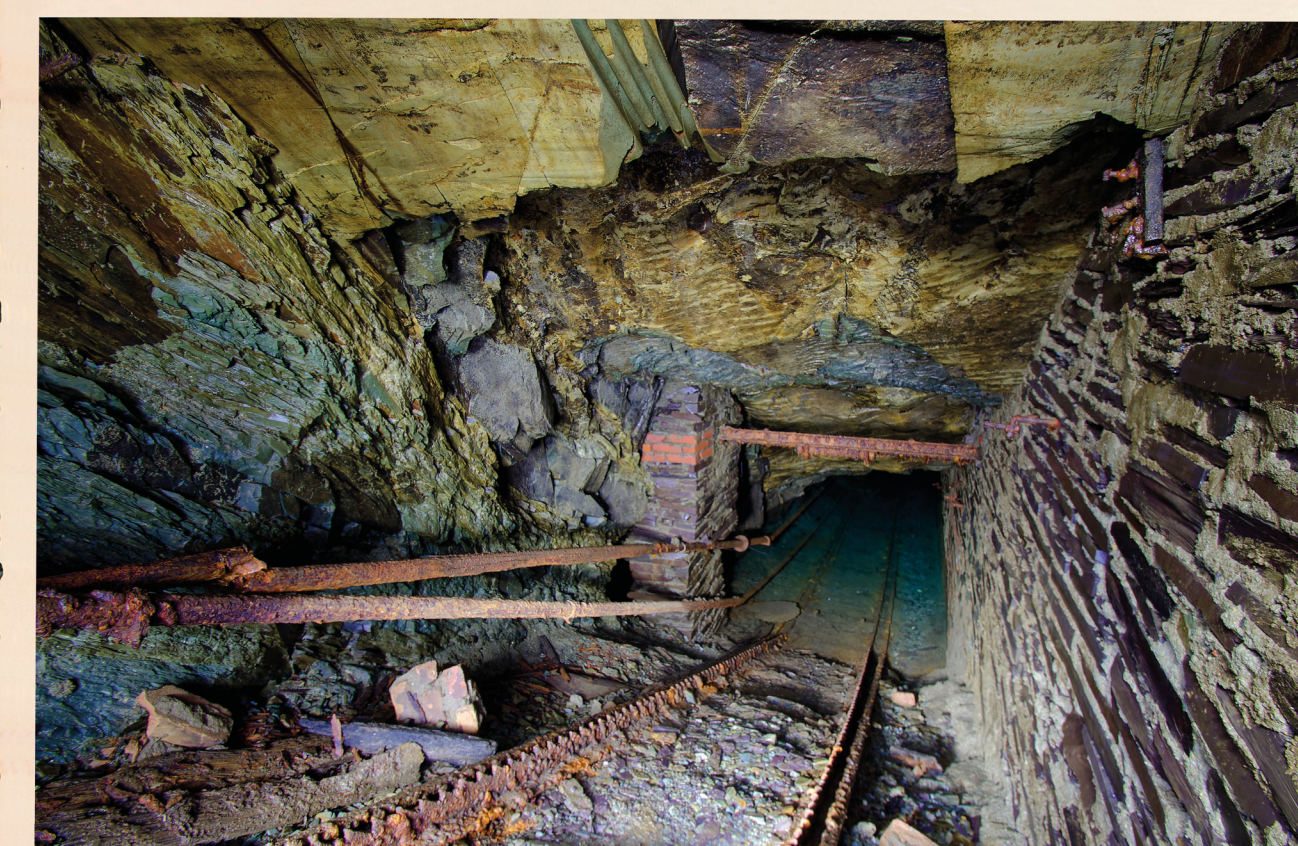
In de afdaling, oude rails en perslucht en waterafvoerleidingen
