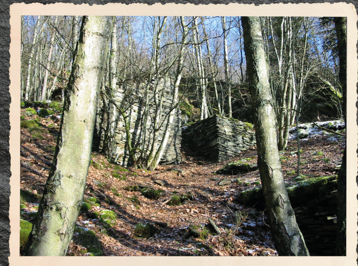
ardoisière St-Martin ou Trou Cadet. Retaining walls © Guy Lépine
